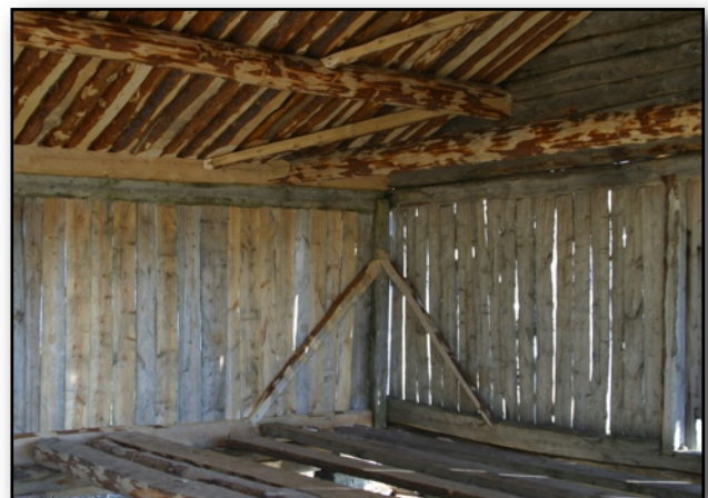
Stav med skråband på høysjå på Lavonjarg i Tana. Skråbanda er av furu som berre er hogd til på tjukna til knapt 2 tommer. Leg også merke til skråbanda mot røstet.
