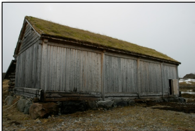
Naust i Kabelvåg med heil steinmur under heile sylla
