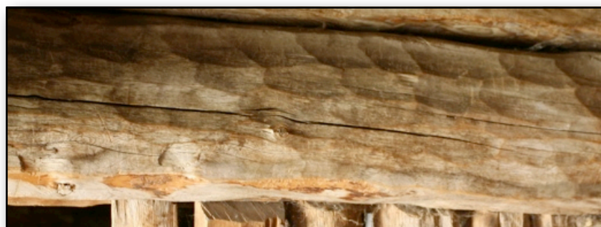
Hogging på tømmeret på Kornlåven på Sjønstå, truleg på 1600-talet
