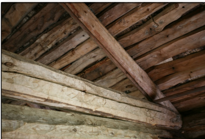
Grøypestokk som også er sperre i Kornlåven på Sjønstå. Her har det truleg vore skjeltring i røste.
