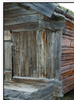
Skjelterskjå i Tana med sleppvegg på langveggen og skjeltring på kortveggane.
