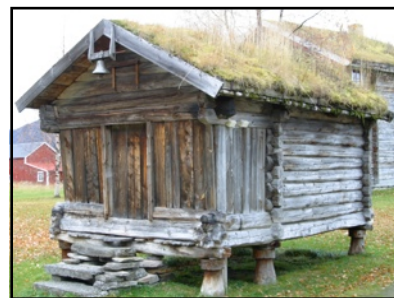
Stabbur i Saltdal med stavar som ber røstveggen.
