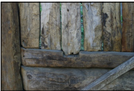
Skjeltre som står i grøypestokk på Skjåen frå Sjøvik. Legg merke til at det er hogd ut for å smette inn og ut skjeltringa.
