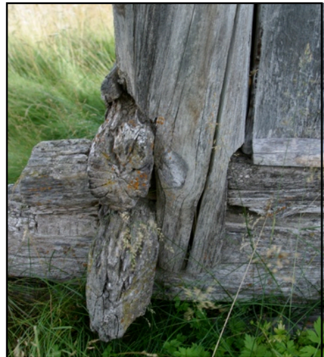
Typisk stavfelling på stabburet ved Storfossen
