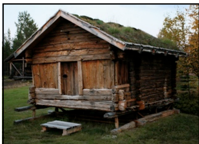
Stabbur i Karasjok der skjeltrane har beringa av røstveggen i eine enden.
