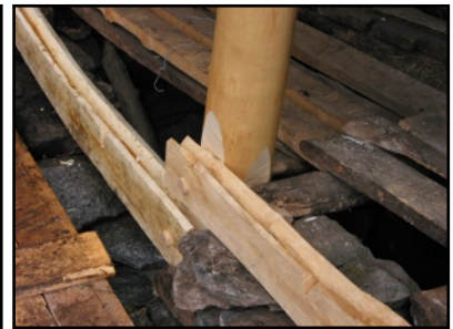
Grøypestokkar i grindbygd løe på Skageflå i Geiranger. Grøypestokkane er nagla fast.
