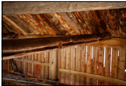
Grøypestokk, truleg frå 1700-talet som er gjenbrukt som samhald i stornaustet på Greipstad på Kvaløya.
