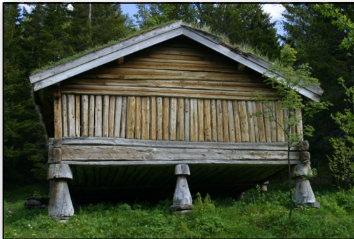
Kornlåve frå Balsfjord med stabbar på flata steinar
